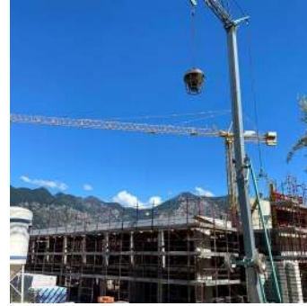
Riva del Garda (TN) — realizzazione appartamenti
