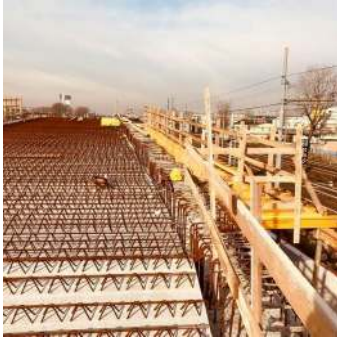
Marghera (VE) — nuova viabilità Macroisola
