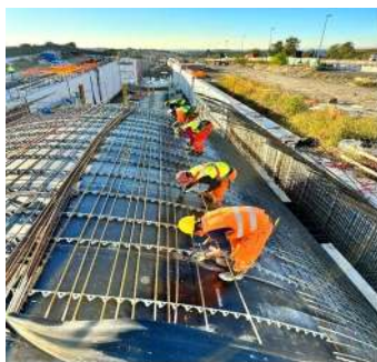
AV/AC Verona-Padova — lavorazione armature impalcato
