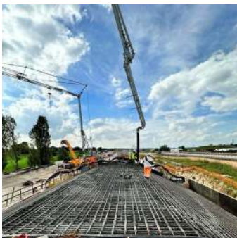
AV/AC Verona-Padova — posa armatura impalcato
