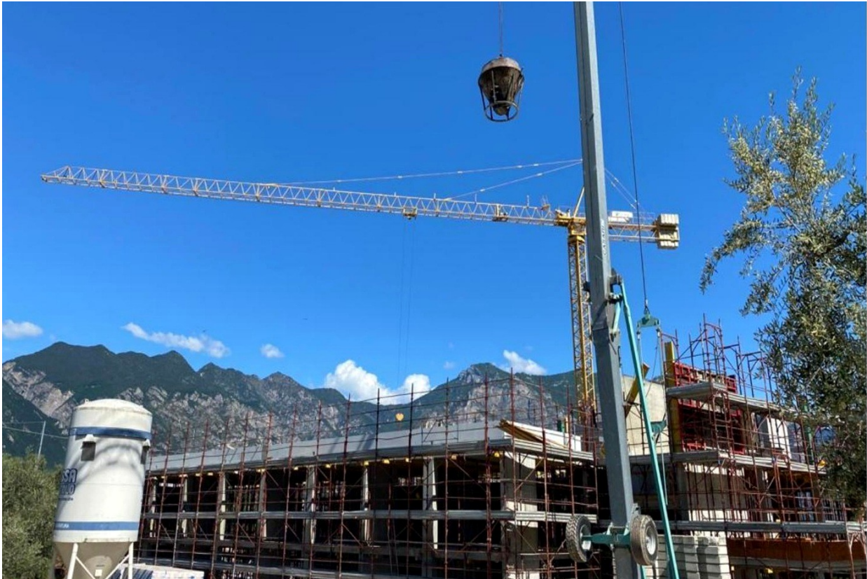
Gru e ponteggi al lavoro in uno dei cantieri Costruzioni AG.
