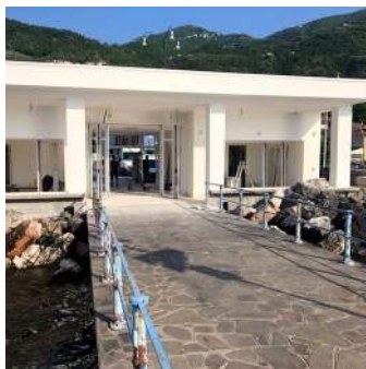
AV/AC Verona-Padova — impermeabilizzazione impalcato
