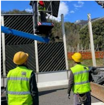
Autostrada del Brennero — barriere fonoassorbenti
