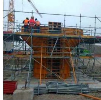
Ti-Bre — spalle e pile bretella Cisa- Brennero
